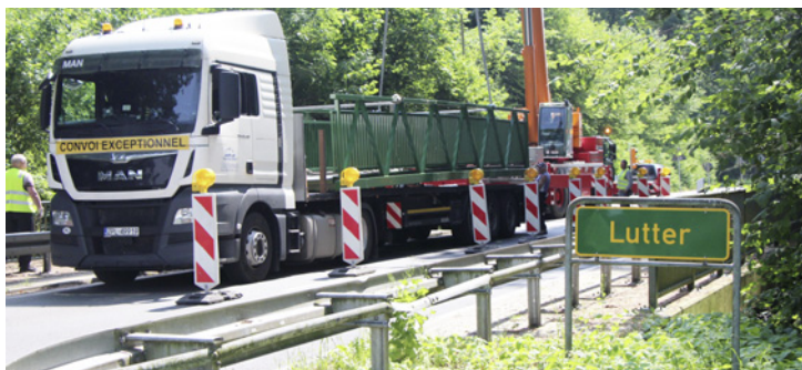
Die Radwegbrücke über die Lutter wurde erneuert. Foto: Christian Ziemke / Kreis Gütersloh
