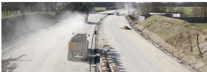
Bauarbeiten auf dem letzten Teilstück der A33-Lücke, Blickrichtung Norden. Foto: Jan Focken/Kreis Gütersloh
