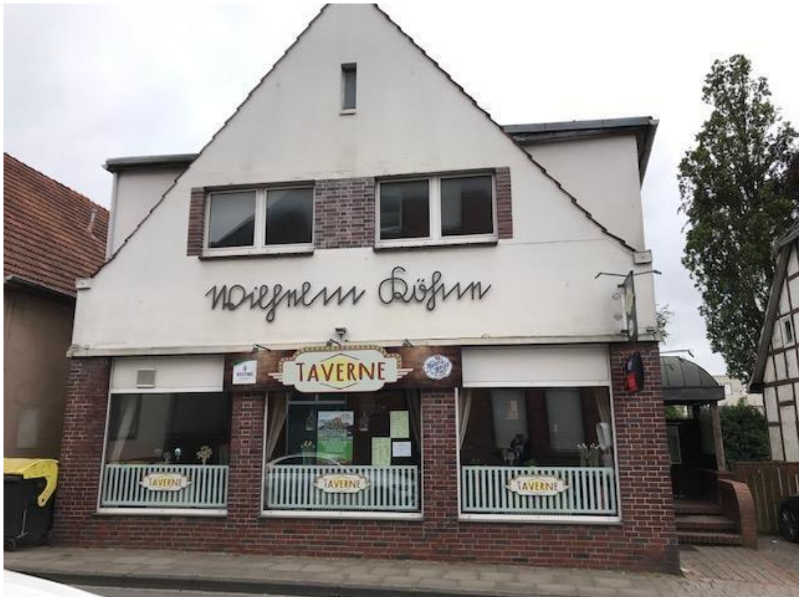
Ansicht in Richtung Südwesten (Nordostseite)
