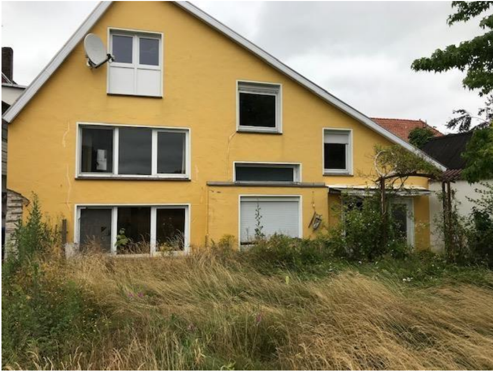
Ansicht in Richtung Nordosten (Südwestseite)
