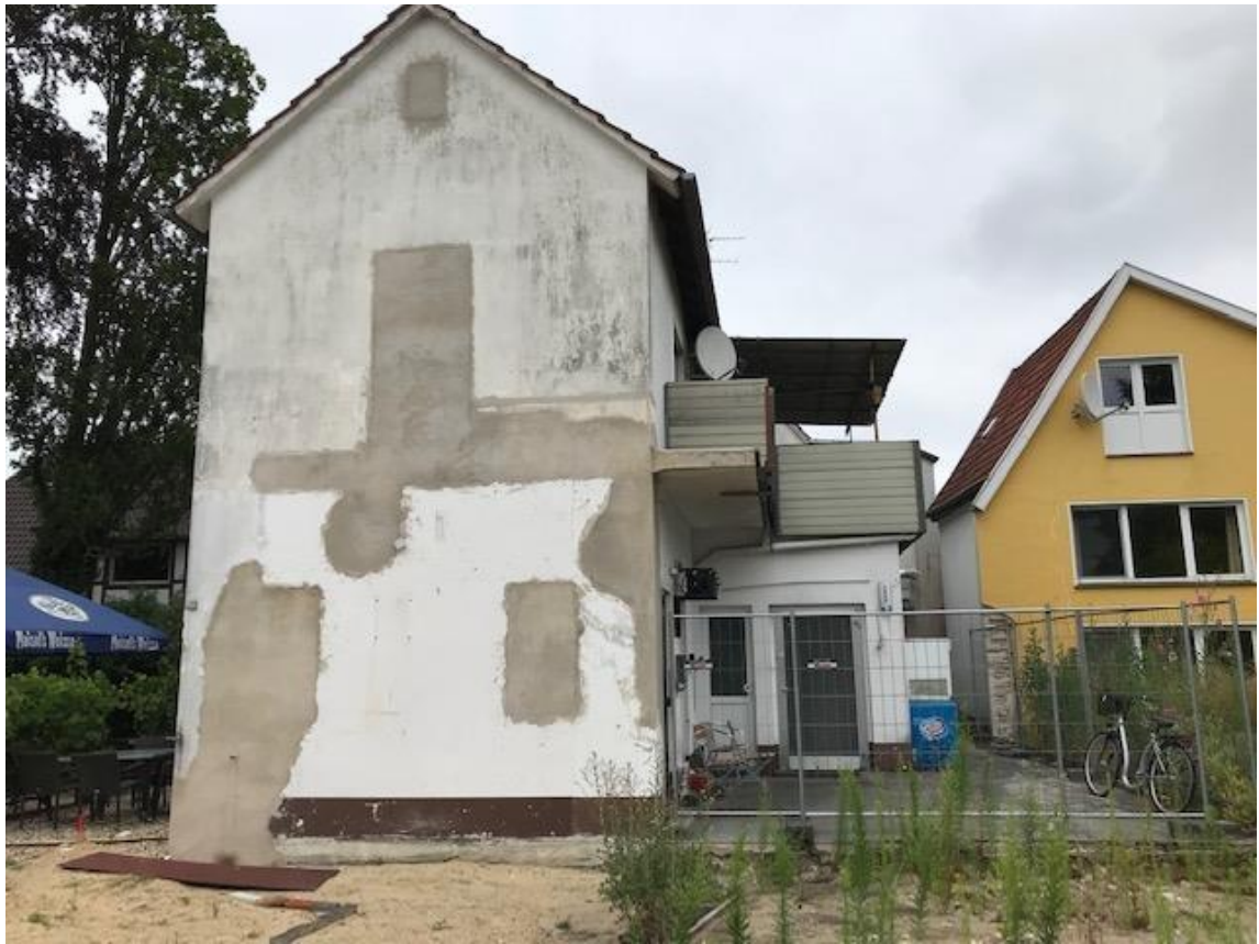
Ansicht in Richtung Nordosten (Südwestseite)
